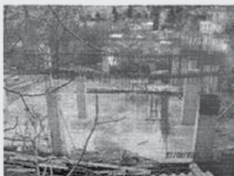
Фотография строящегося дома, сделанная от стены Музея.
